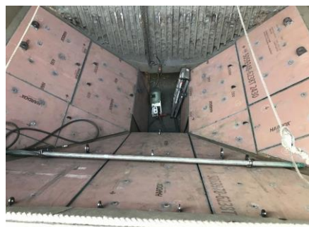
耐摩耗鋼HARDOX400 ホッパーライナー
