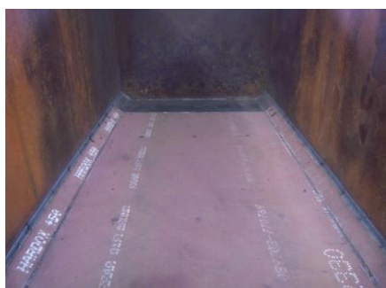
耐摩耗鋼HARDOX450 コンテナ床張り
