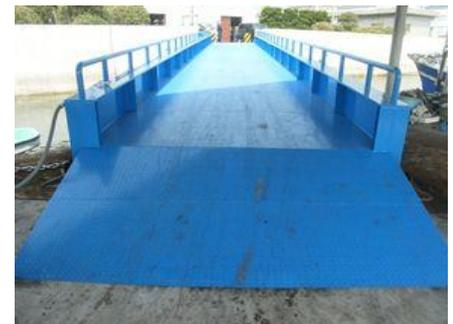
鋼製単純桁渡橋
