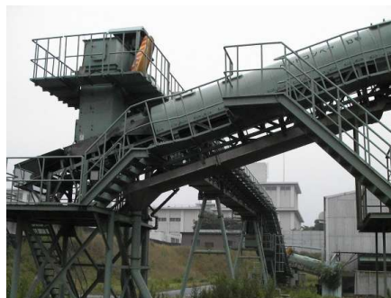
複数基連動式ベルトコンベヤ製造事例
