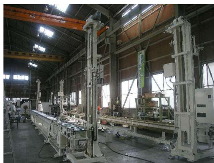
垂直搬送装置 地下搬送機
