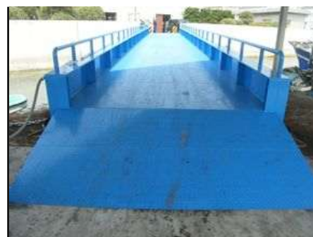
鋼製単純桁渡橋
